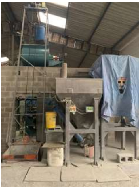
Figura 4 – Equipamento onde é realizada a pesagem dos agregados e cimento e onde é transportado o material até o misturador (fonte: Acervo pessoal, 2020).
