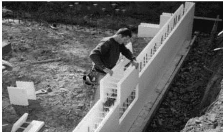
Figura 11 - Encaixe dos segmentos EPS
