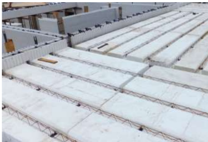
Figura 16 - Laje com o sistema ICF
