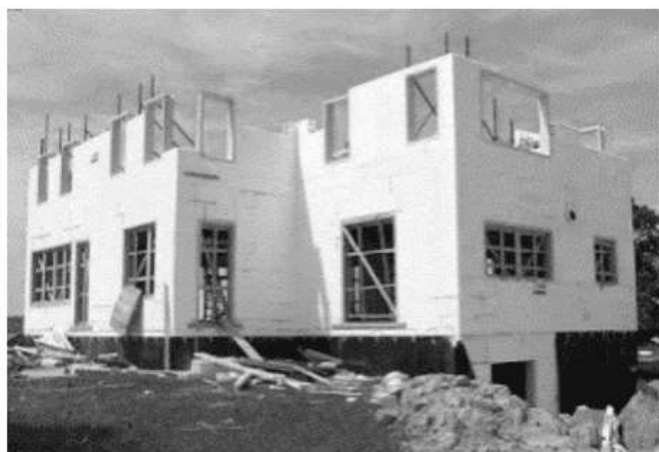
Figura 14 - Abertura de esquadrias e impermeabilização
