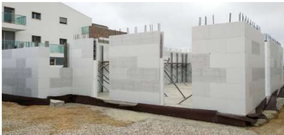
Figura 12 - Paredes com o sistema ICF
