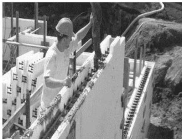
Figura 13 - Concretagem das paredes de EPS
