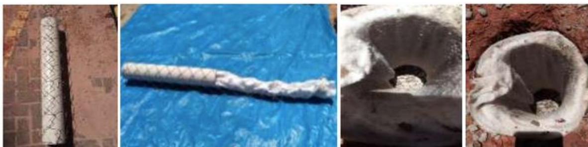
Figura 6: duto vertical drenante
