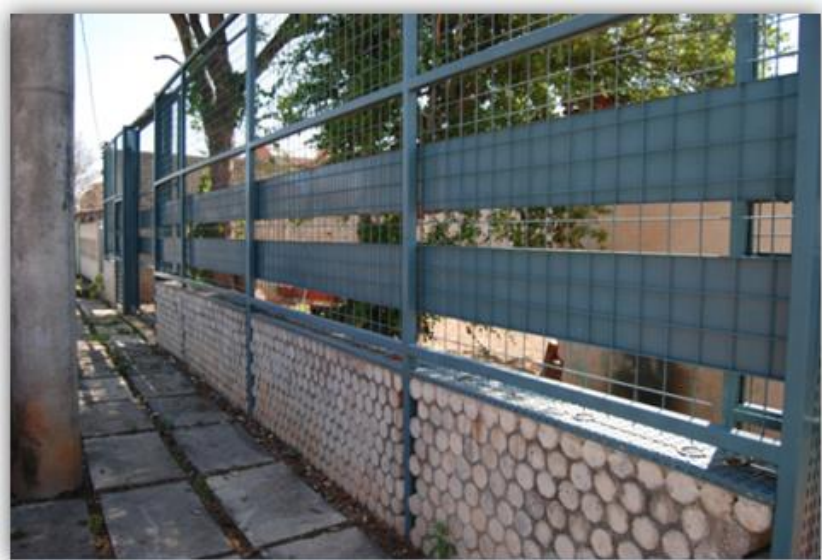
Figura 8- Portão e grade confeccionados a partir de perfil metálico, eletro calhas e malha pop.
