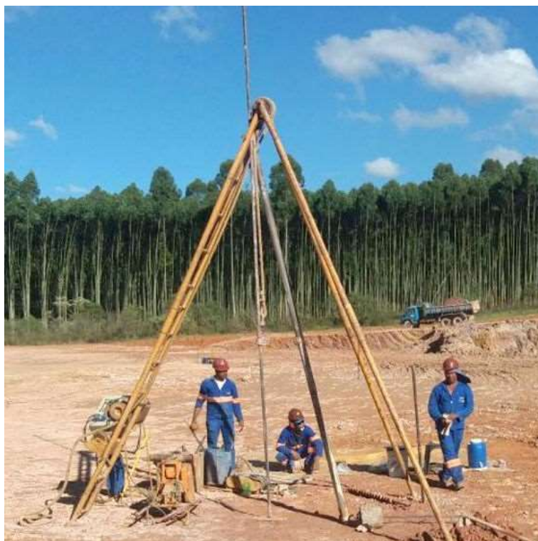
Figura 1 - Execução de uma sondagem SPT
